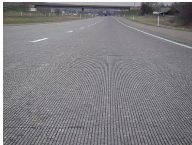
شکل ۱- اجرای عملیات شیار انداختن بر روسازی‌های بتنی
